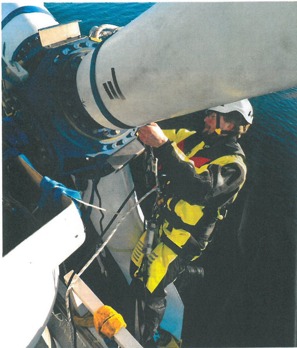
Trygg: Service på vindturbiner offshore. Kombinasjon av arbeidsantrekk og overlevedesdrakt.
